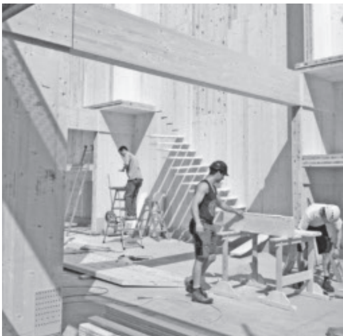
Bauamtsgebäude im Bau.
