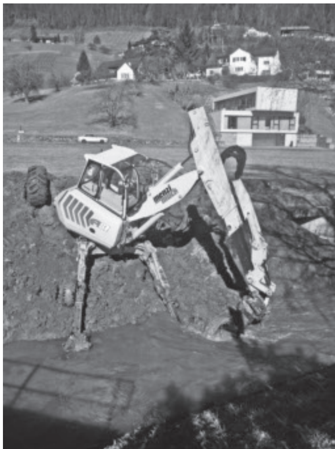
Ausbaggern des Littenbachs im Frühjahr 2012.
