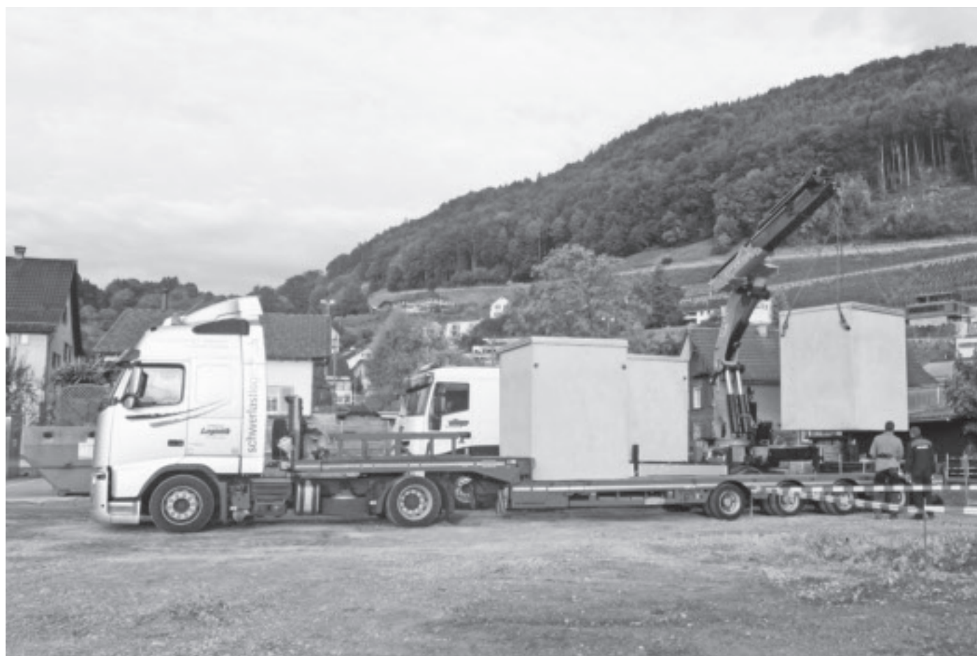
Versetzen der neuen Unterflurcontainer bei der zentralen Sammelstelle.
