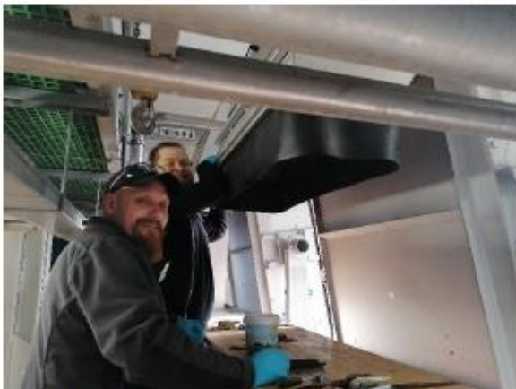
Gummilippe ersetzen Auswurf Harkenrechen
