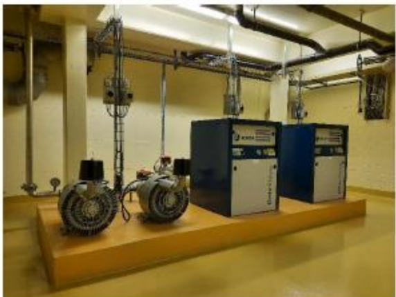
Neue Verdichter (Mammutpumpe), neue Gebläse (Belüftung)
