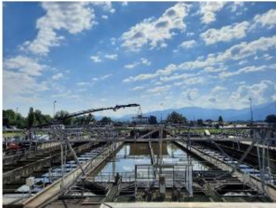
Montage Stahlbau, Tragwerke über den Becken der Vorklämung, Denitrifikation und Nachklärung
