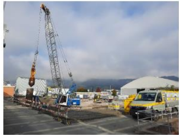
Einvibrieren von 15 m langen Spundwandprofilen zur Bildung einer dichten Baugrube
