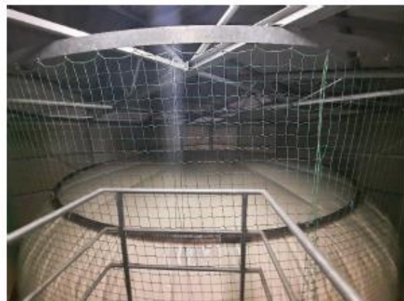
In fünf Arbeitstagen mit zwei Mann neue Speicherhülle montiert, Lebensdauer mindestens 15 Jahre
