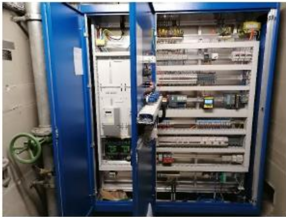
Neuer Schaltschrank und Ersatz EMSRL im PW Fussgänger-Unterführung
