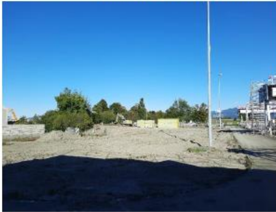
Abtrag Oberboden (Humus) und Unterboden
