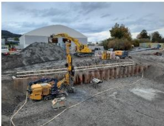
Rückverankerung der Spundwände
