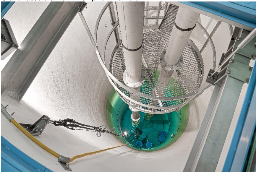
Grundwasserbrunnen 1 Pumpwerk Au Nord
