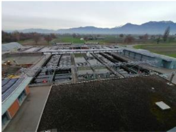
Faltdach eingefahren, keine Stromproduktion
