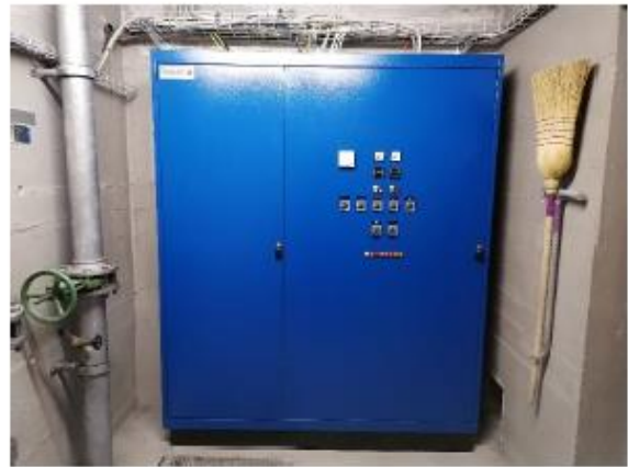
Neuer Schaltschrank und Ersatz EMSRL im PW Fussgänger-Unterführung
