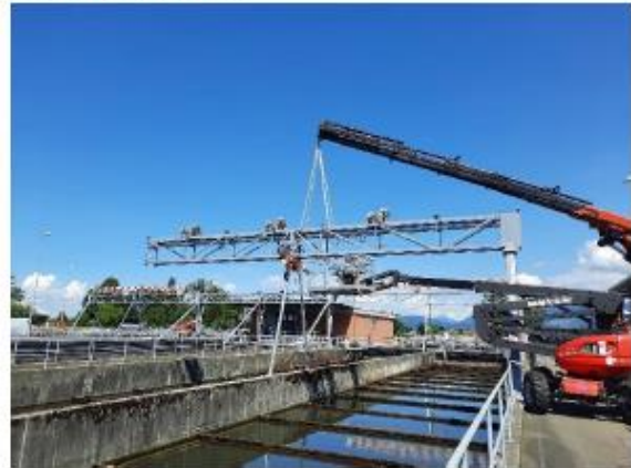
Montage Stahlbau, Tragwerke über den Becken der Vorklämung, Denitrifikation und Nachklärung
