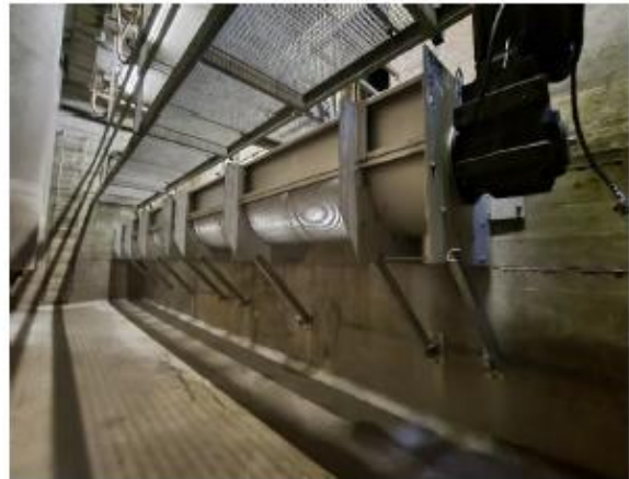
Einbau Siebrechen im Pumpensumpf des HWPW Neugrütt 2
