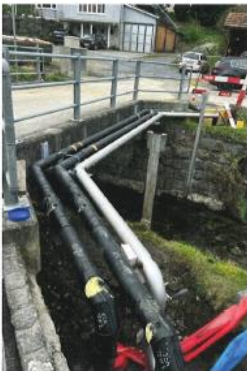
Bachquerung zur Erschliessung
