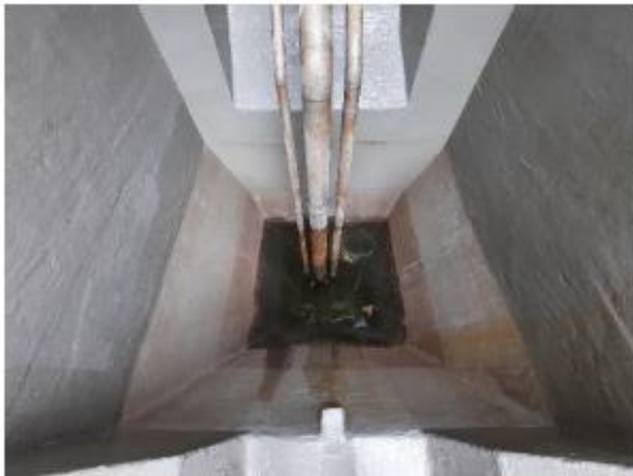
Betonsubstanz wurde beschichtet, neue Rohrleitungen Mammutpumpe
