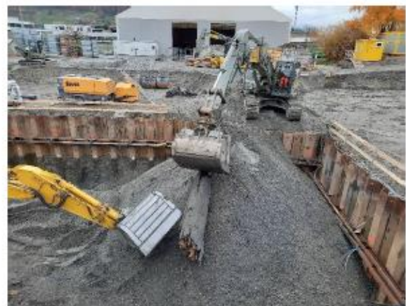
Bei Aushubarbeiten eine "uralte" Schottereiche gefunden
