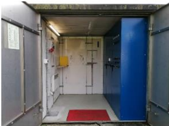
Pumpwerk Erlen, Ersatz EMSRL inkl. Schaltschrank
