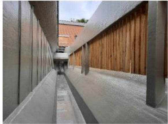
Neue Trennbalken aus Eiche zum Oel-/Fettfang
