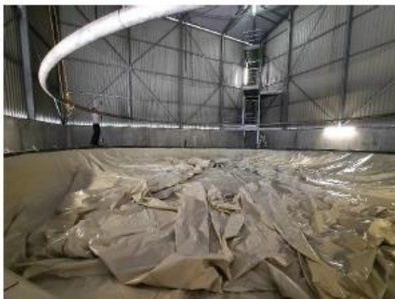
In fünf Arbeitstagen mit zwei Mann neue Speicherhülle montiert, Lebensdauer mindestens 15 Jahre
