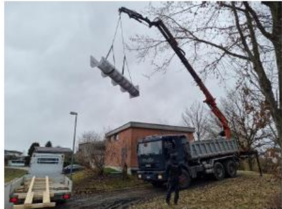
Hochwasserpumpwerk (HWPW) Neugrütt 2, Ersatz EMSRL und Anlieferung des Siebrechens
