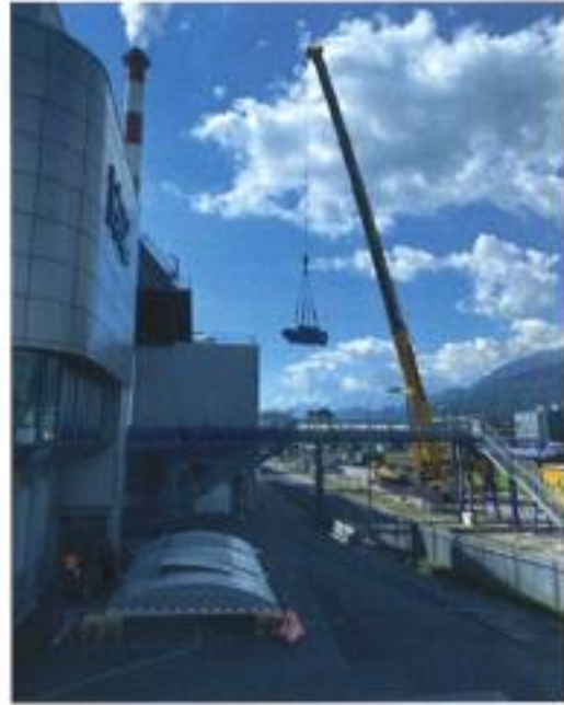
Ausheben des Generators, Gesamtgewicht 35 Tonnen; benötigter Kran Gesamtgewicht 450 Tonnen
