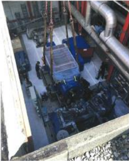
Ausheben des Generators, Gesamtgewicht 35 Tonnen; benötigter Kran Gesamtgewicht 450 Tonnen
