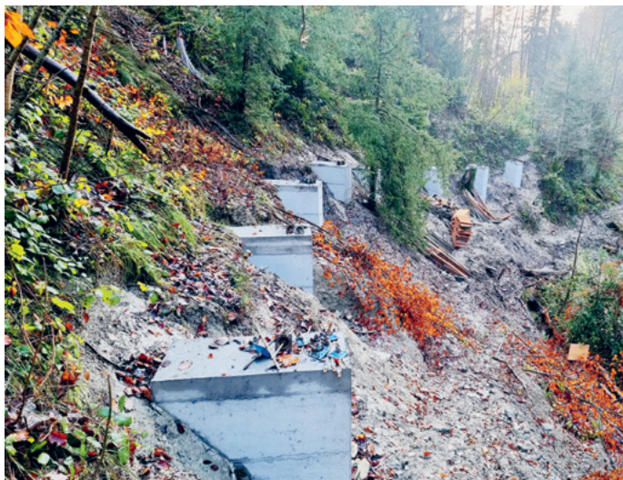
Neu erstellte Fundamente für den Wanderweg Taatobel
