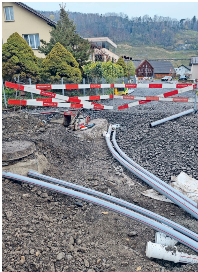
Gesamtsanierung im Kreuzungsbereich der Rosen- und der Feldmülistrasse
