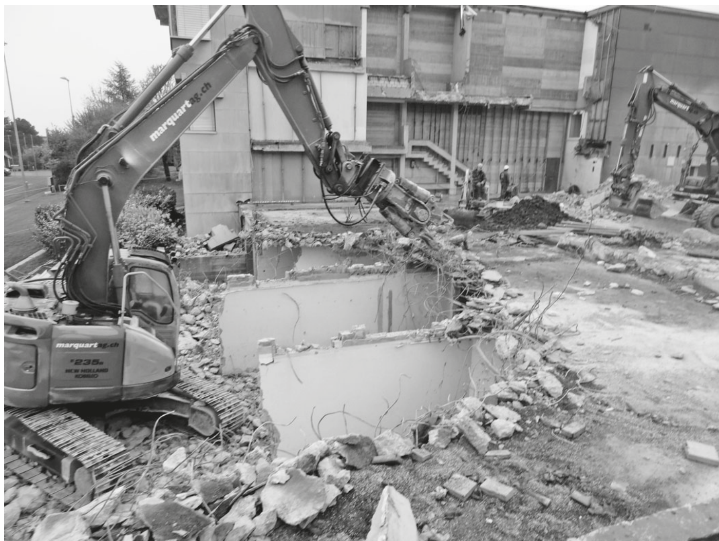
Abbruch Zwischentrakt Schulhaus Stäpfli
