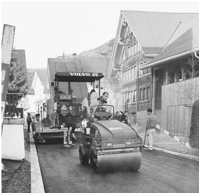
Tiefbauarbeiten an der Kirchgass im Herbst 2020
