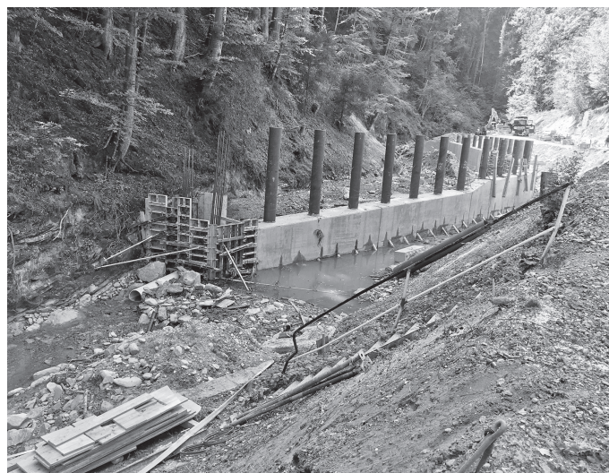
Betonarbeiten am Holzrückhalt Papieri im Sommer 2018
