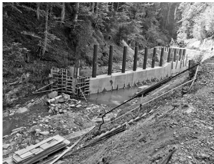
Betonarbeiten am Holzrückhalt Papieri im Sommer 2018
