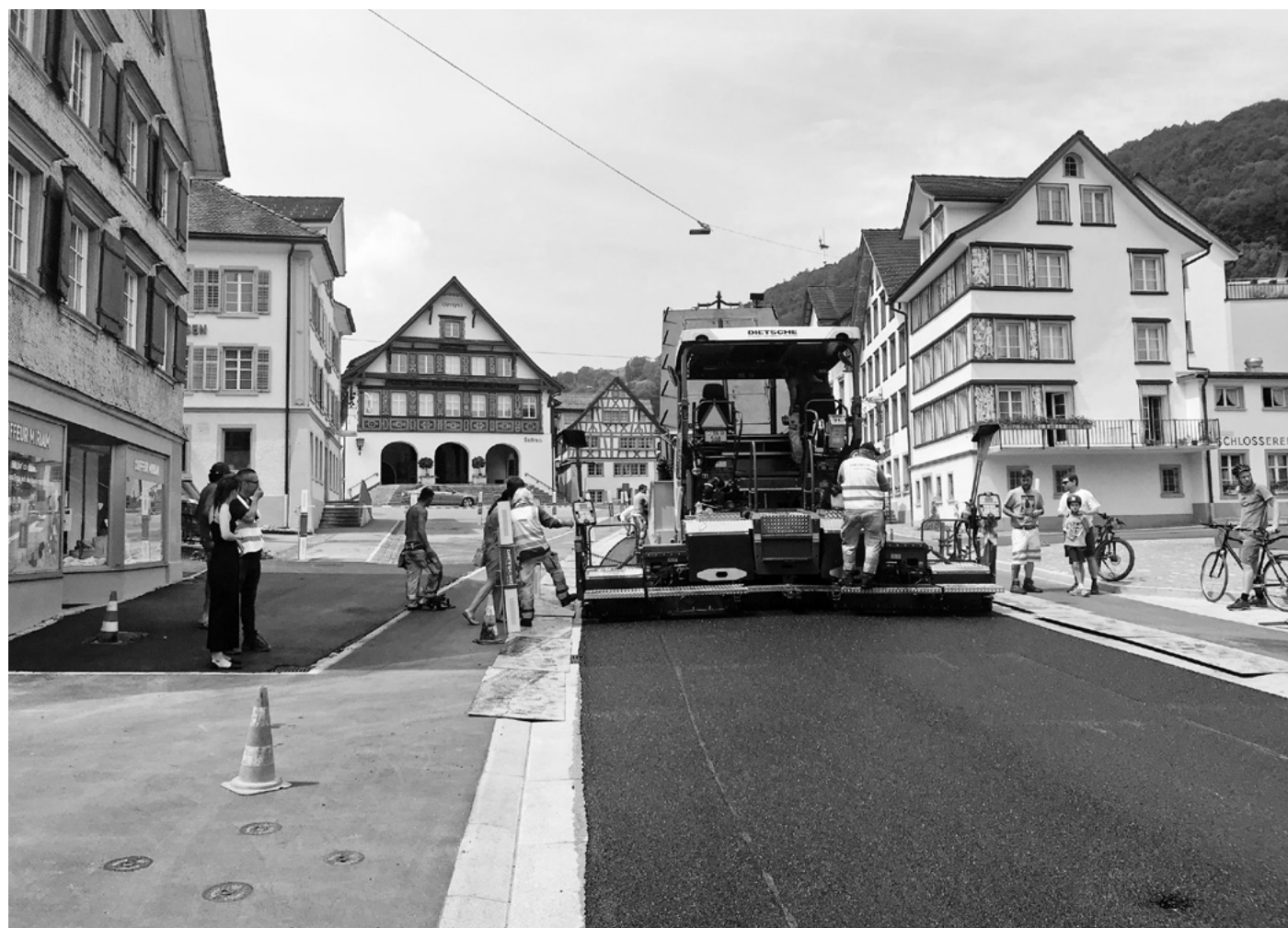
Die Neugass wurde an einem Sonntag für die Einbringung des Deckbelags gesperrt.
