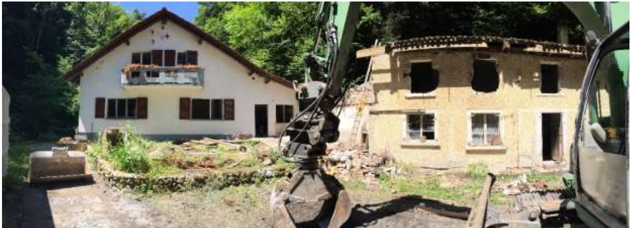
Abbruch der Gebäude in der Papieri
