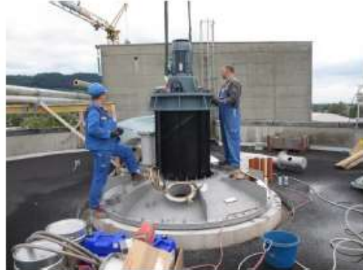
Einführen des ca. 15m langen Saugrohres und anschliessend des Mixers
