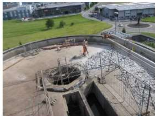
Der Dachbelag wird entfernt
