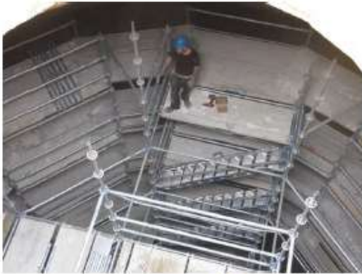
Das Innengerüst im FR1
