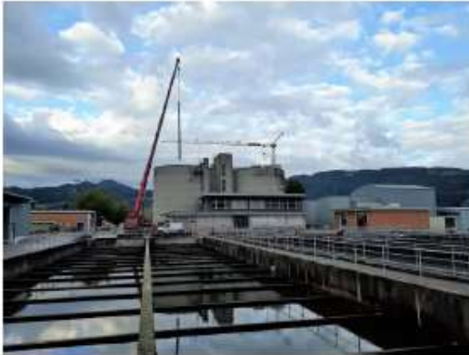
Einführen des ca. 15m langen Saugrohres und anschliessend des Mixers
