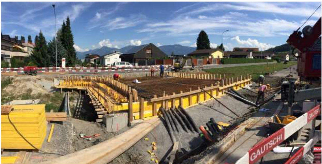
Arbeiten an der neuen Kropfackerbrücke.
