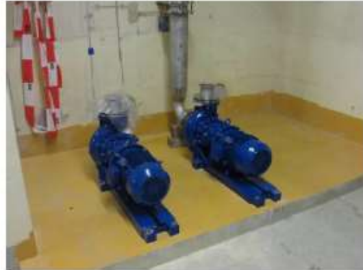
Zusätzlicher Mazerator und neue Pumpen im Aufheiz-Kreislauf des FR1
