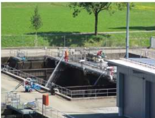
Reinigungs- und Wartungsarbeiten BB3
