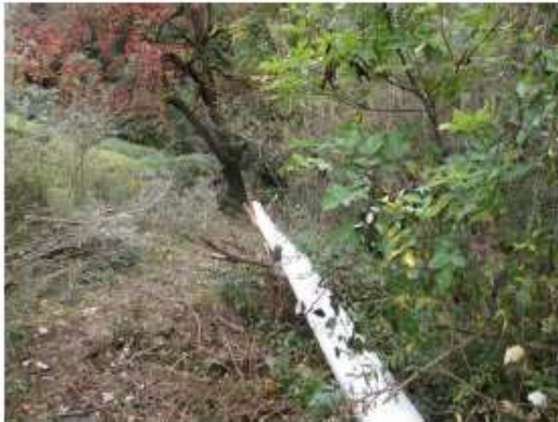
Provisorisch gelegte Kanalisation (Hangrutsch)
