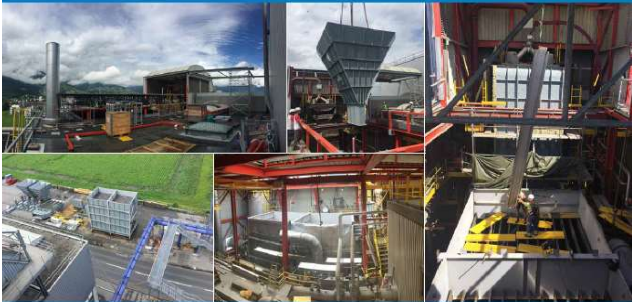
Ersatz Elektrofilter 1
