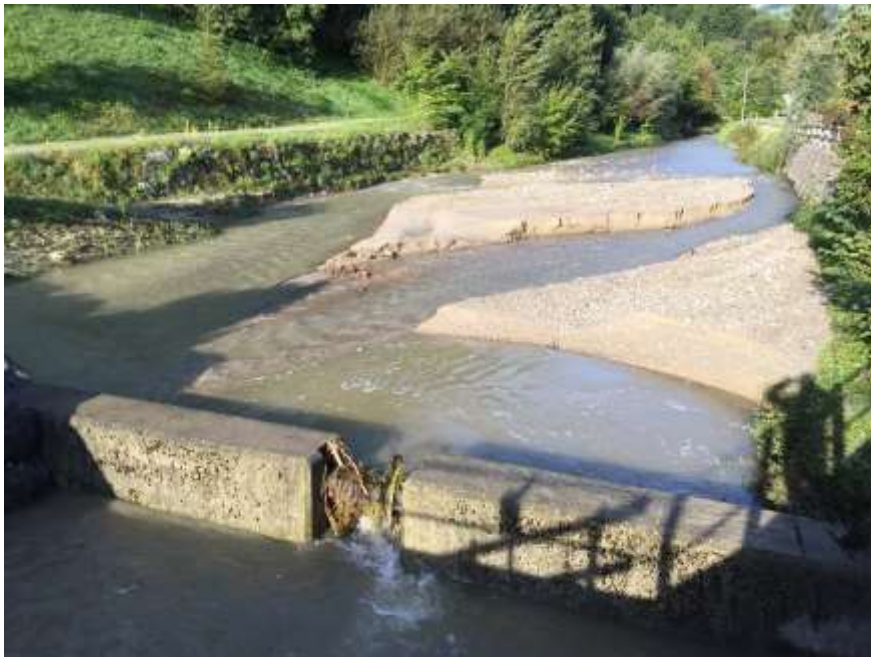
Voller Schlossbruggsämmler nach dem Hochwasser
