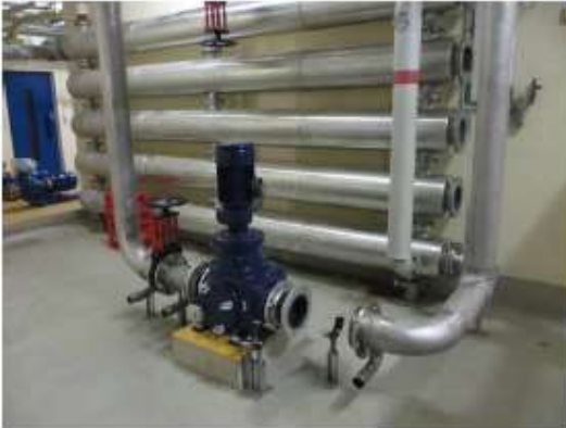
Zusätzlicher Mazerator und neue Pumpen im Aufheiz-Kreislauf des FR1
