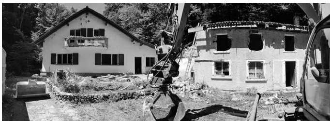
Abbruch der Gebäude in der Papieri.
