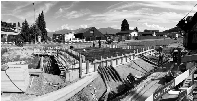
Arbeiten an der neuen Kropfackerbrücke.
