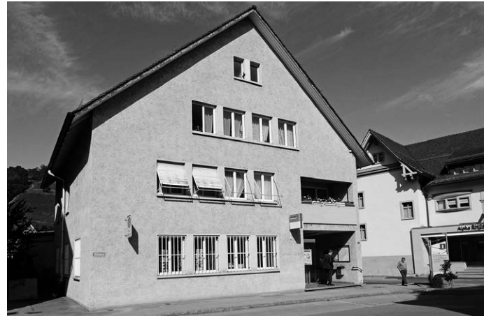
Im Wohn- und Geschäftsgebäude Neugass 23 entsteht ein neuer Volg-Verkaufsladen mit Postagentur.
