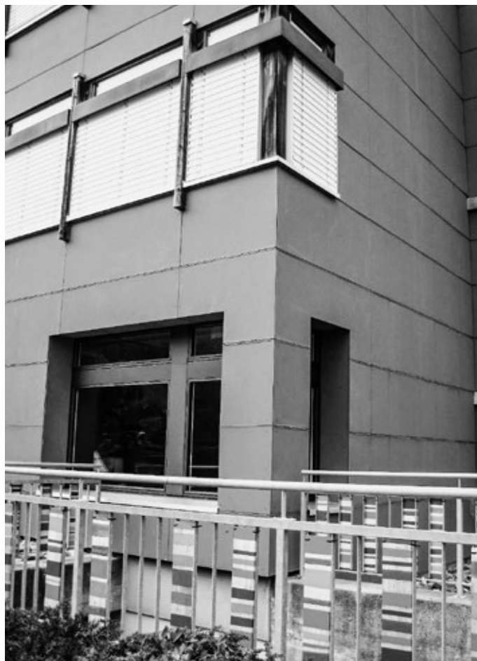
Die neuen Fenster bringen viel Helligkeit in den südlichen Teil der Bühne der Aula Stäppli.
