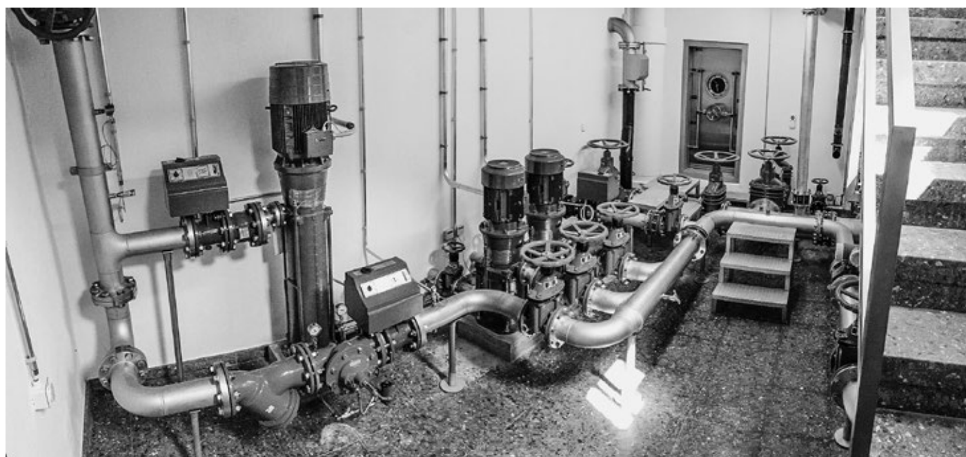
Rohrkeller Reservoir Röthiberg
