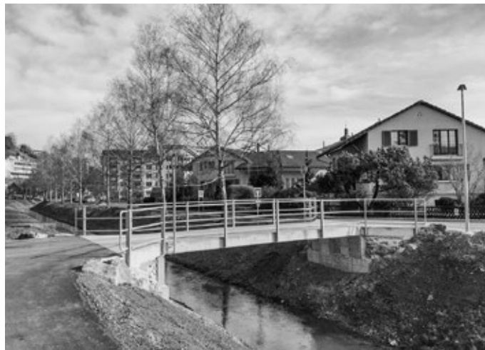
Neue, provisorische Kobelbrücke
