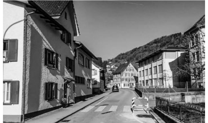
Sofortmassnahme beim Schulhaus Bünt
