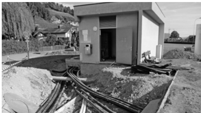
Sanierung Trafostation Unterfeld
